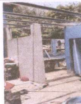
Foto 2: Puerta de lámina por una de metal, medidas de las puertas 2.00 m de altura por 1.00 m de ancho.
