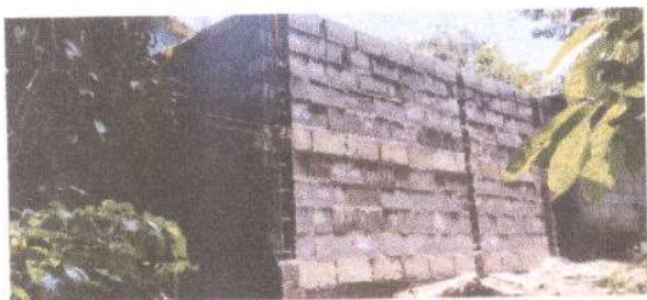
Foto 9: Se realizará muro de lamina por block 6 metros de ancho por 6 metros de largo y altura 2.70 (36 m2)
