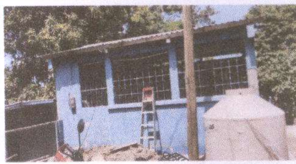
Foto 2: Mantenimiento de balcones de metal, lijado aplicación de pintura. 8 m².
