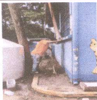
Foto 5. Reparación de banqueta de concreto por filtración de agua al salón de clase del exterior al interior. 12 m².
