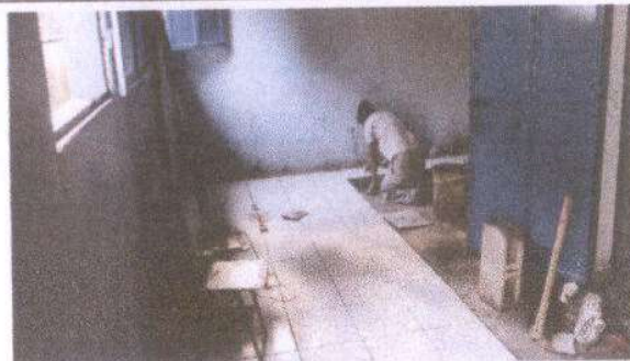
Foto 2: Se colocará piso cerámico ya que se tiene el conveniente de que es torta de cemento y es difíci su aseo. Con total de 22 metros.
