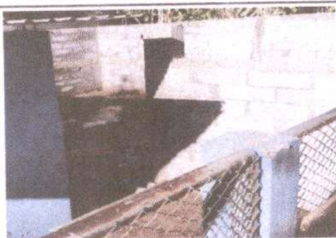
Foto 3: Piso de torta de concreto. 40 metros
