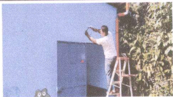
Foto1: Reparación y mantenimiento a puerta de metal por exposición directa a la lluvia. (aula 1)
