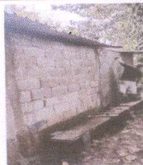
Foto 6: Se repellará la parte externa de los baños ya que se filta agua y el deterioro es constante. 30 metros.
