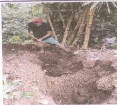
Foto 8: Limpieza de fosa séptica para un mejor servicio de los ambientes.
