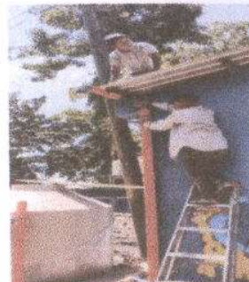
Foto 4: Reparación y mantenimiento de bajada de agua pluvial
