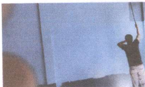
Foto 4: Pintura en muros interiores y exteriores. 60 metros
